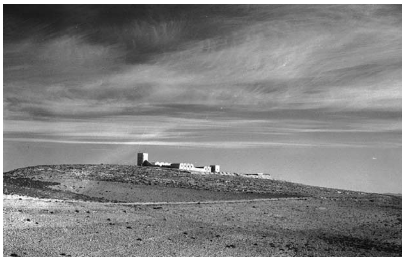
מצודת ביריה בסיום בנייה, נובמבר 1947. צלם: דורי ויסנשטיין, באדיבות ארכיון הצילומים של קק"ל
